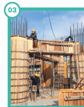
03 現場で組み立て
