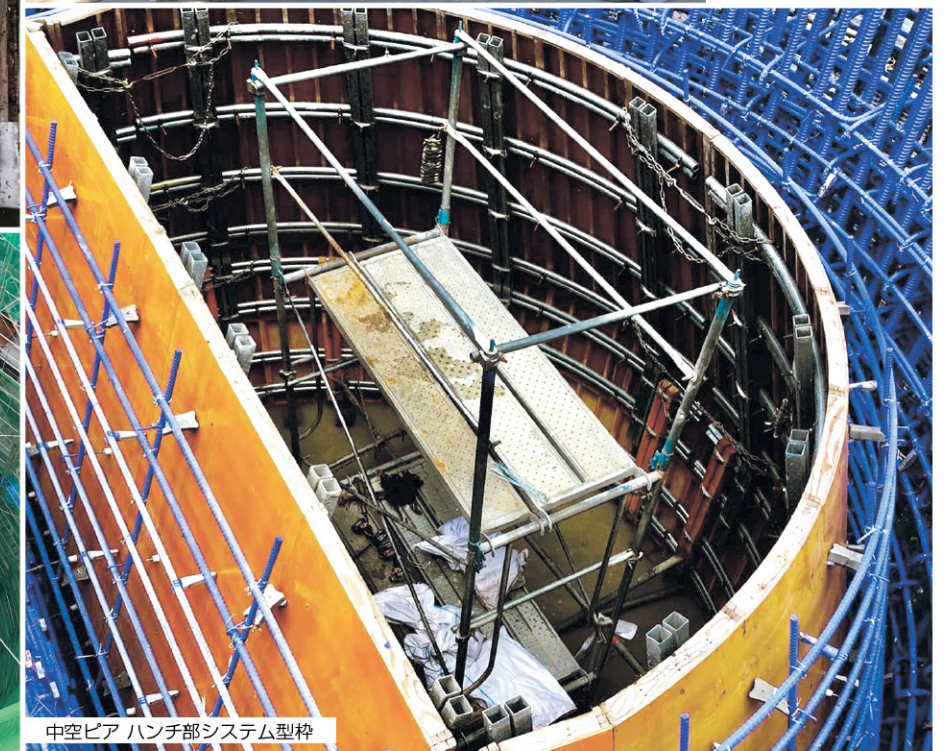
橋脚下部工大組型枠
