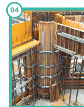
04 鋼材で締め固め
