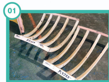
01 構造物の形状の骨組みを製作
