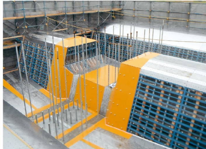
上部工全面施工
