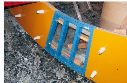
トンネルインパート
