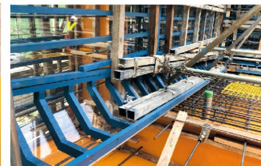
ワーゲン上部工
