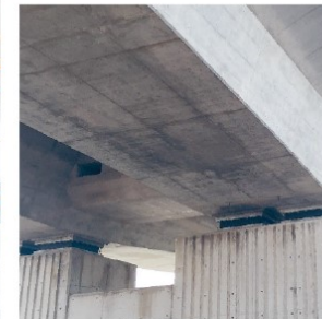
上部工仕上がり
