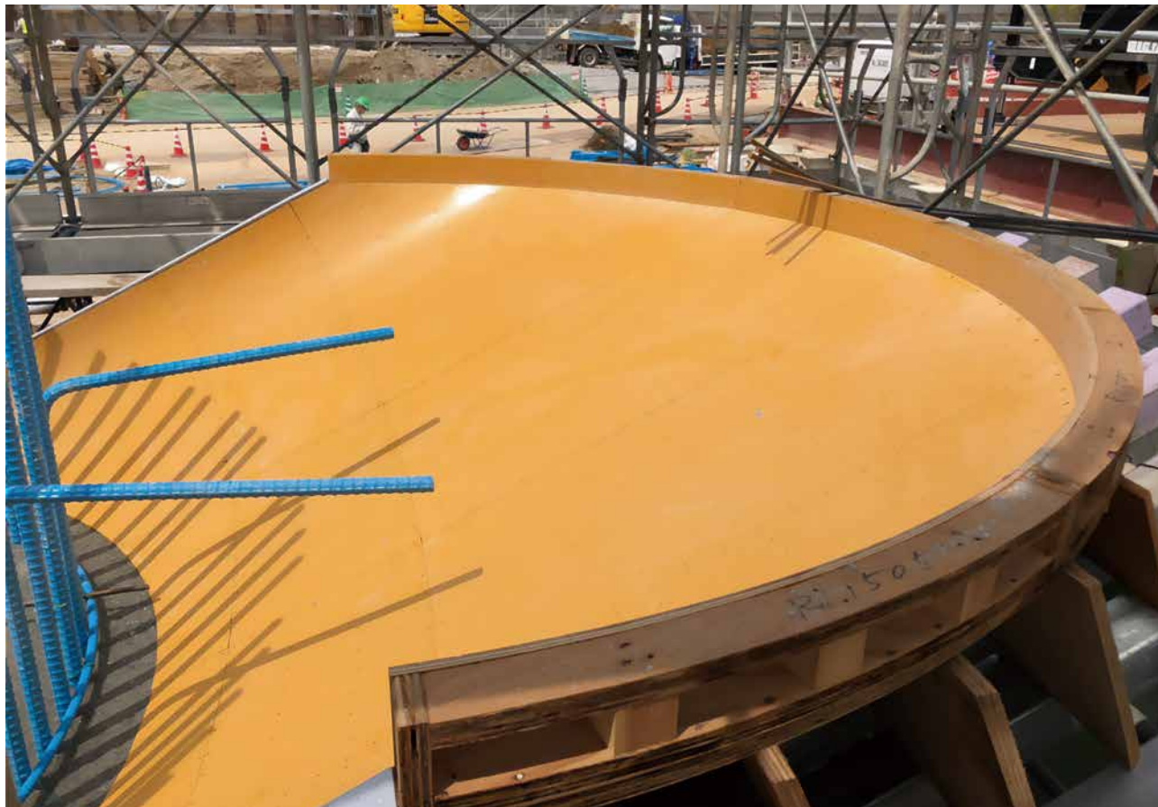
橋脚梁底型枠
