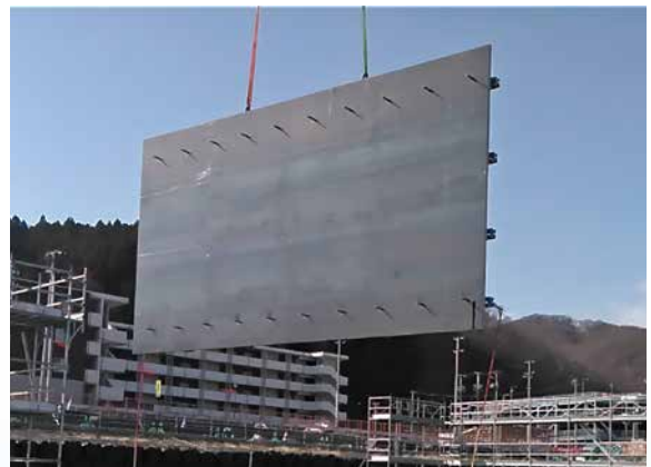
システム型枠吊り込み
