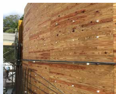
円形杉板本型枠階段
