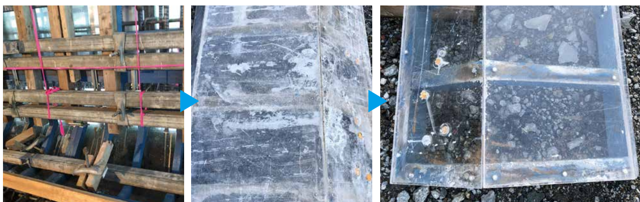
型枠建込の様子
