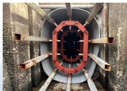
管更生支保工
