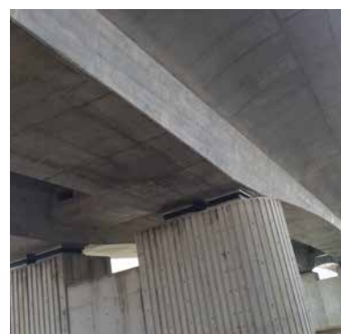
上部工完成躯体
