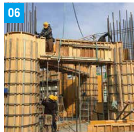
現場で組み立て
