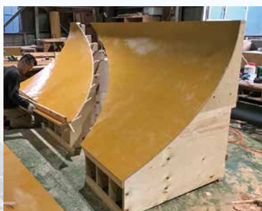
大型舟底型枠
