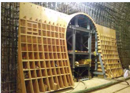
避難坑バラセントル
