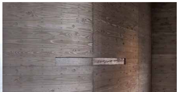
円形杉板本型枠階段
