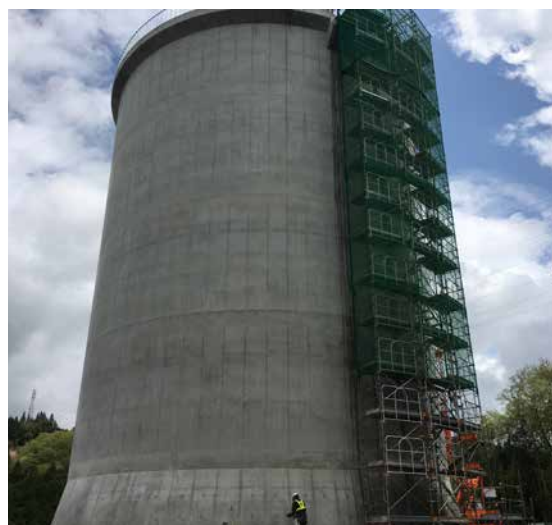
水力発電用貯水槽
