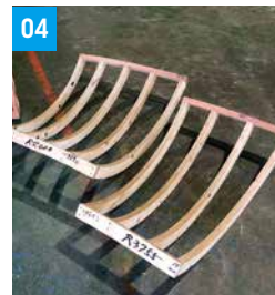
構造物の形状の骨組みを製作
