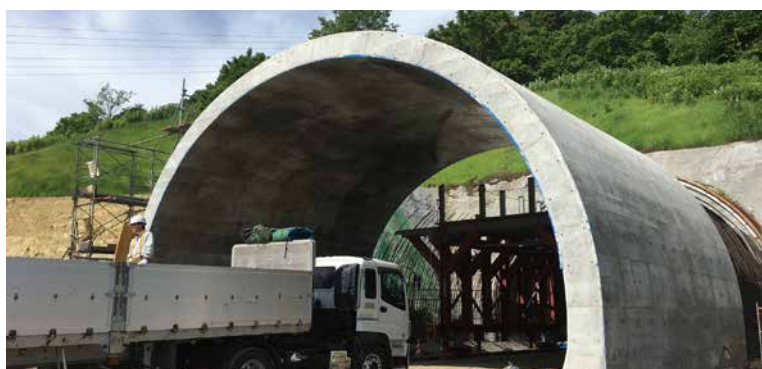
トンネル坑門工躯体
