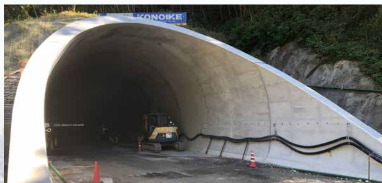
トンネル竹割坑門工躯体
