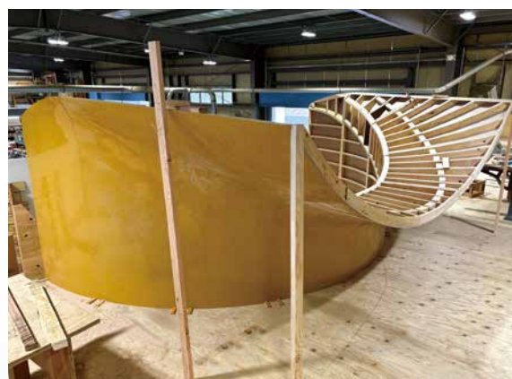
3重アール型枠
