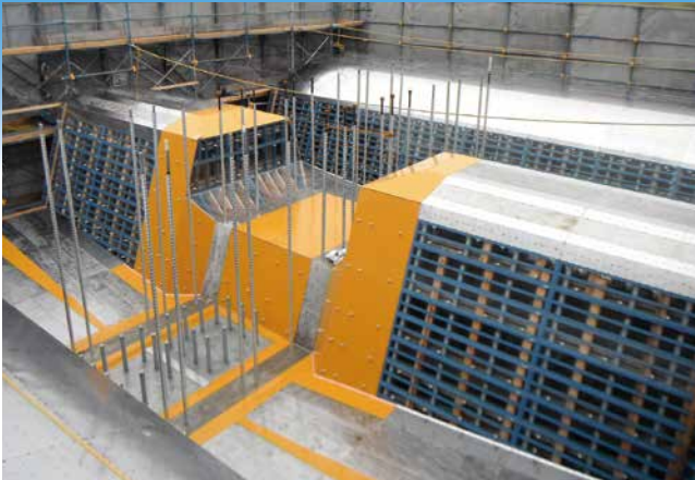
上部工全面施工
