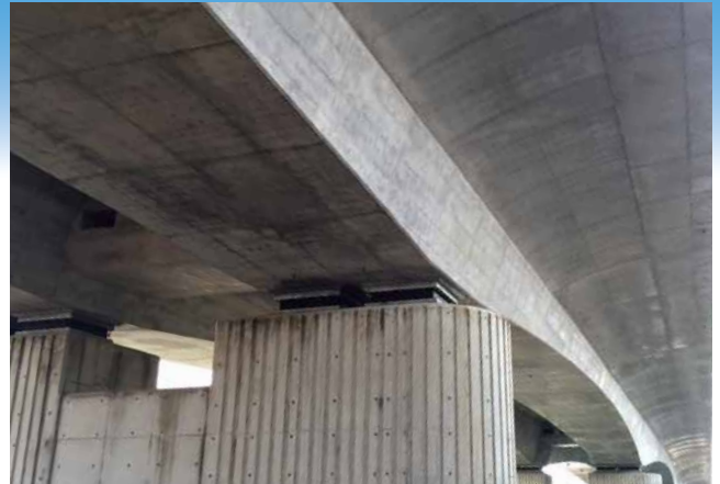
上部工仕上がり
