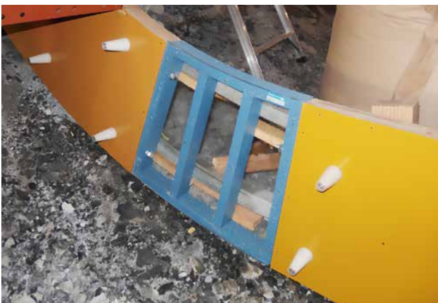
トンネルインパート
