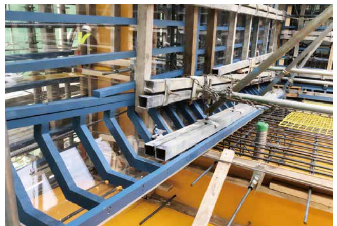
ワーゲン上部工
