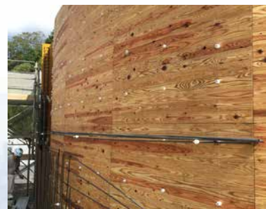
円形杉板本型枠階段
