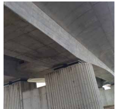
上部工完成躯体
