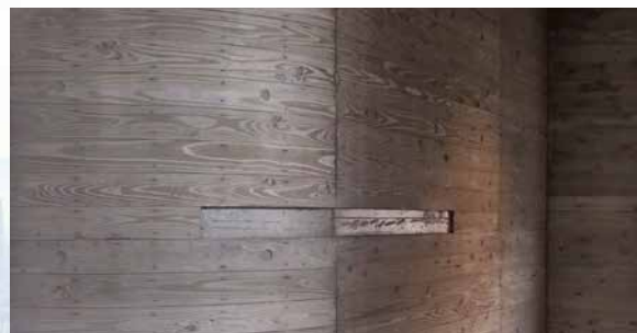
円形杉板本型枠階段
