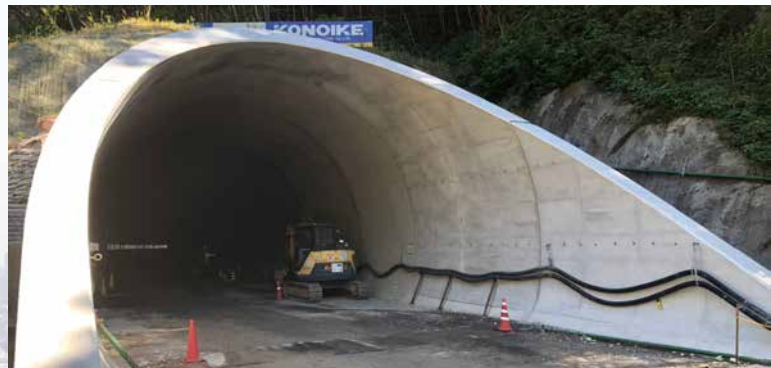
トンネル竹割坑門工躯体
