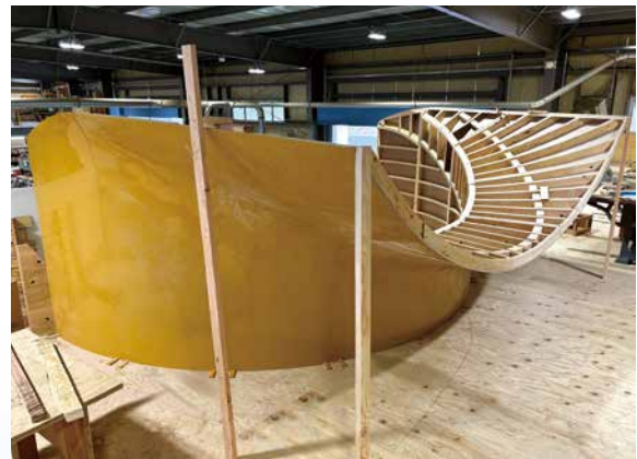
3重アール型枠
