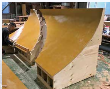
大型舟底型枠
