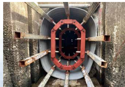
管更生支保工
