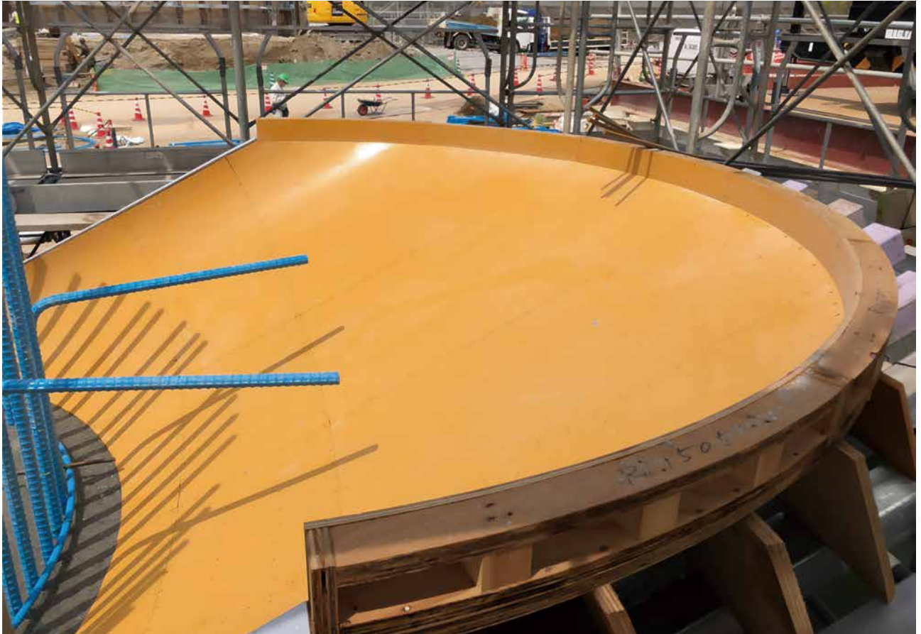
橋脚梁底型枠
