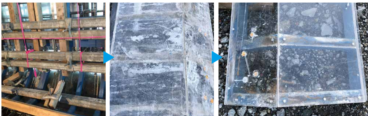
型枠建込の様子
