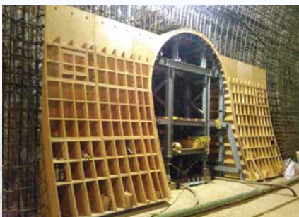
避難坑バラセントル
