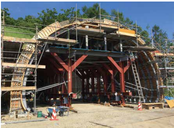
坑門工バラセントル
