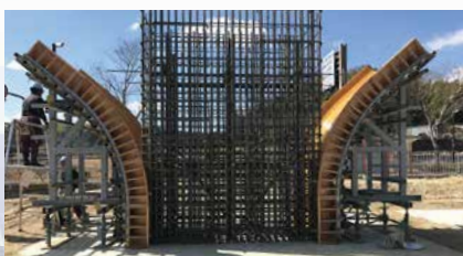
橋脚下部工大組型枠
