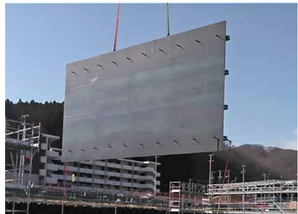
システム型枠吊り込み
