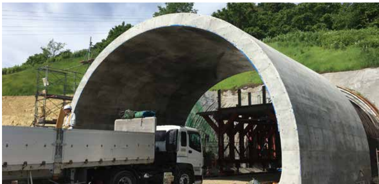
トンネル坑門工躯体
