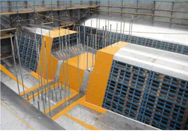
上部工全面施工
