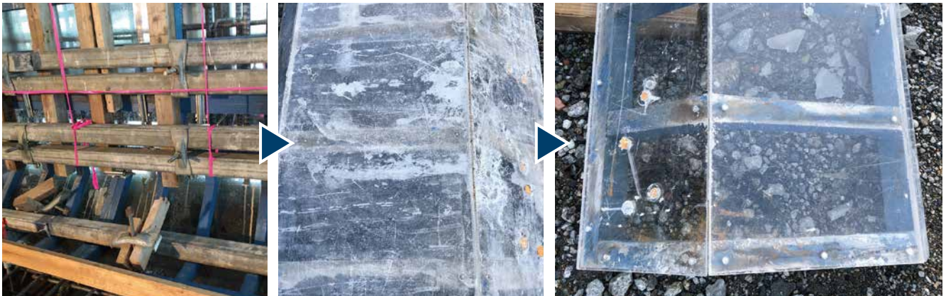
型枠建込の様子
