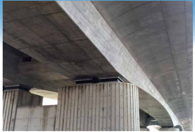
上部工仕上げ
