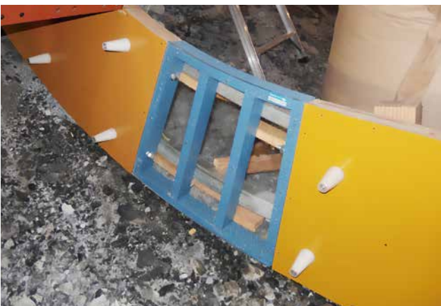
トンネルインパート
